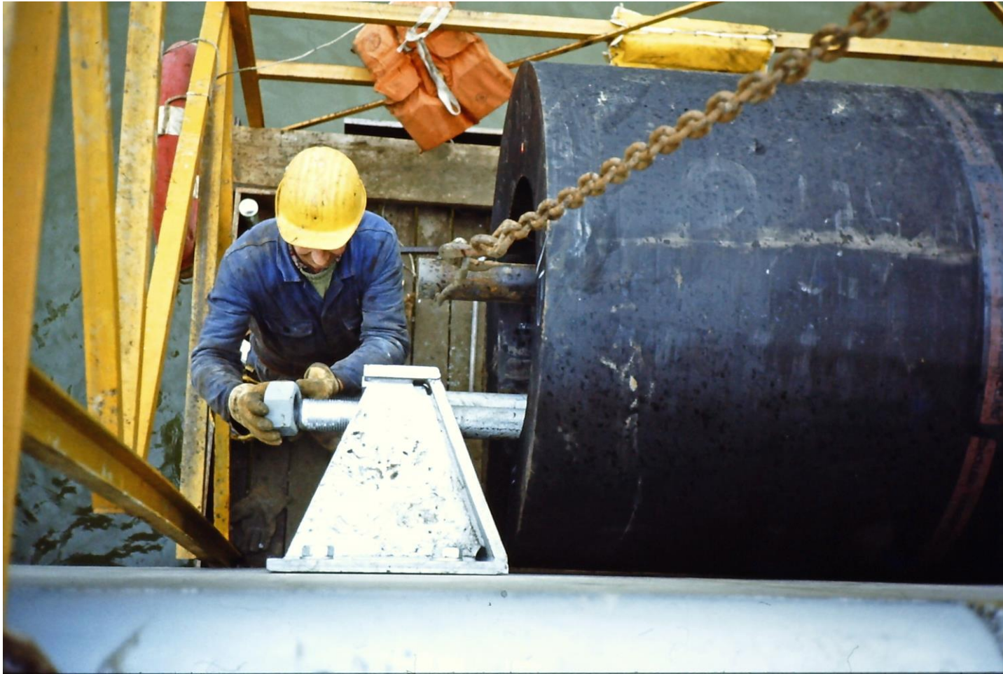
Vrasenedok Fase I en II Monteren van de cilinder fenders
